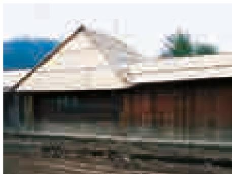
Figura 13. Utilidad del tejamanil como tapa en los plafones y como teja en las cubiertas.
