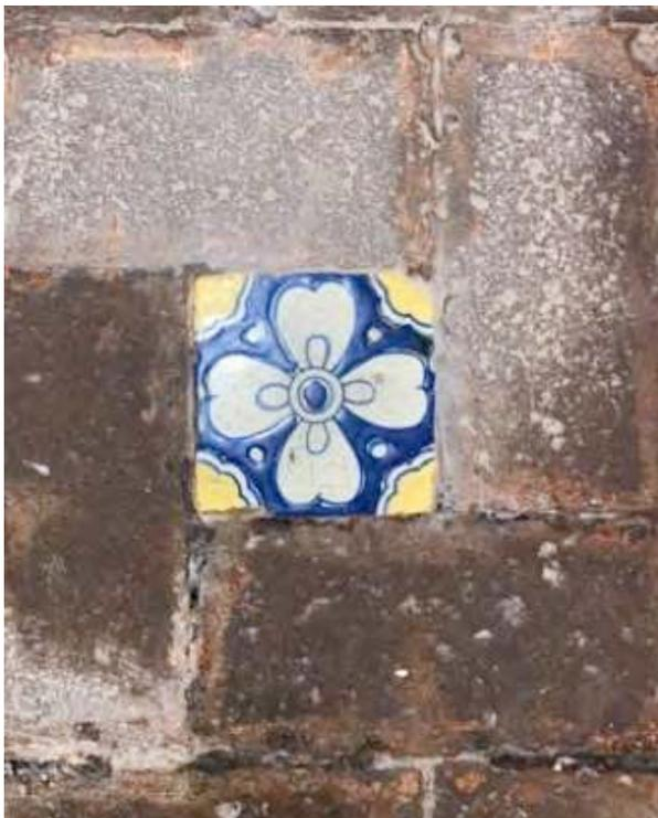
*Ilustración 175. Erosión de ladrillos y juntas de cemento en el piso de la cocina. Foto: Tomás Meraz, 2022.*
