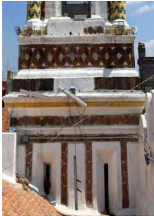
*Ilustración 124. Pérdida de piezas de solera y sustitución por mortero de cemento. Foto: José Ignacio Lanzagorta, 2022*
