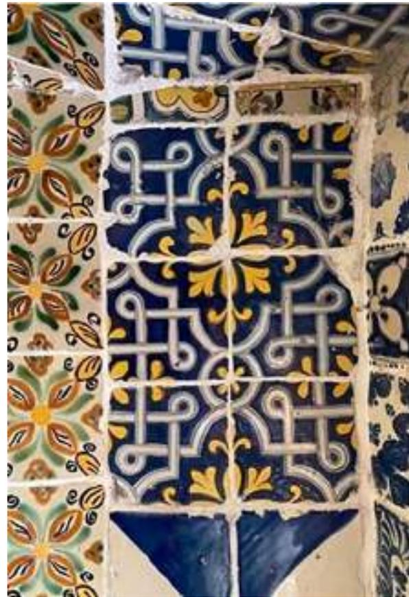
*Ilustración 162. Nicho para colocar utensilios de cocina. Se puedan observar azulejos de cuarto con diseño de lacerías blancas y guirnaldas amarillas, combinado con azulejos de medio pañuelo. Los azulejos de decoración fitomorfa que se encuentran a la izquierda de la imagen son de manufactura reciente. Foto: Tomás Meraz, 2022.*
