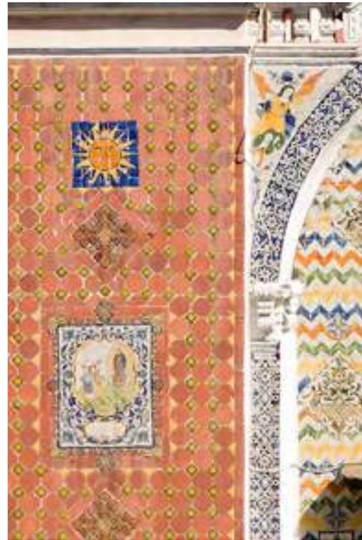
*Ilustración 87. Los paramentos laterales están realizados con base en un patrón cuadrangular, con soleras de ladrillo hexagonales, en cuyos lados se inserta un azulejo de talavera. Se observan cuatro tableros con escenas de las apariciones de la Virgen de Guadalupe, dos a cada lado de la fachada. También se observan dos tableros más pequeños, uno representa al sol y el otro a la luna. Foto: Tomás Meraz, 2022*
