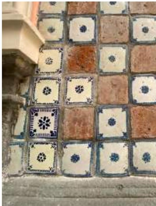
*Ilustración 210. Detalle del panel de la fachada sur de la planta baja del patio donde hay pérdida de material por cristalización de sales. Se aprecian piezas que han sido sustituidas, ya que las originales se han perdido. Foto: Tomás Meraz, 2022.*
