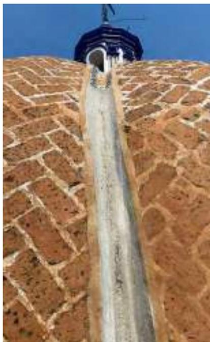
*Ilustración 60. Detalle de una de las canalizaciones de la cúpula, que ya ha perdido las piezas de talavera cóncavas, y han sido sustituidas por resanes de cemento. Fotografía: Tomás Meraz, 2022.*
