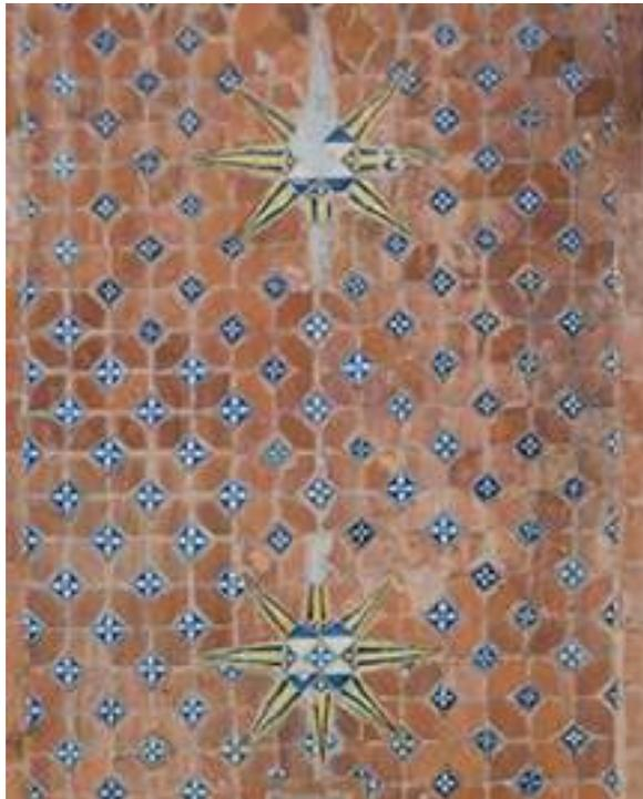
*Ilustración 63. Detalle en el que se aprecian las estrellas de ocho puntas del paramento que culmina con la torre. Se observan faltantes restituidos con resanes de cemento. Fotografía: Tomás Meraz, 2022.*
