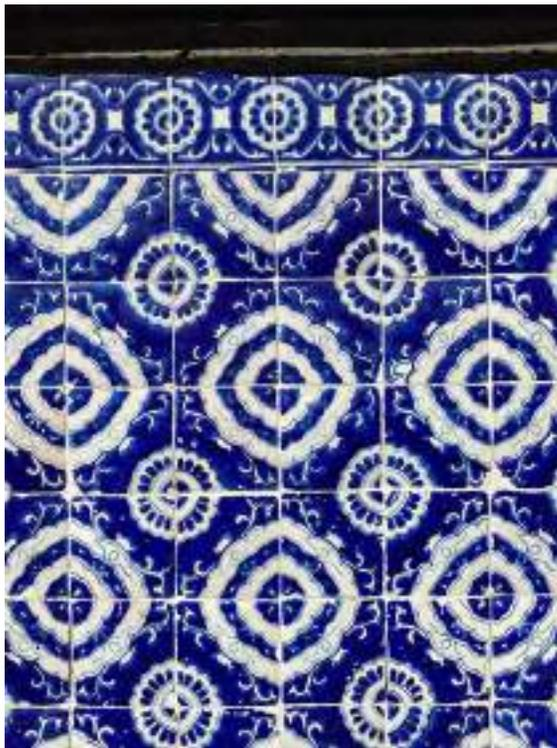
*Ilustración 195. Lambrín de planta baja. Detalle del patrón de azulejos de a cuarto. Se observa que el diseño se conforma por cuatro piezas, y el lambrín se enmarca por una hilada de piezas de talavera rectangulares. Ambos diseños con decoración fitomorfa azul sobre blanco. Foto: Tomás Meraz, 2022.*
