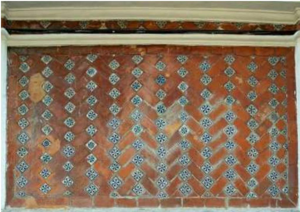
*Ilustración 187. Detalle de uno de los paramentos que dan a la calle 5 de mayo, se puede ver la heterogeneidad de color en el ladrillo, posiblemente debido a la utilización de un hidrofugante. Foto: Tomás Meraz, 2022.*
