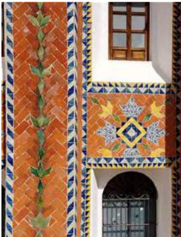
Ilustración 144. Detalle de la fachada Norte. En la cara de los contrafuertes se observa un diseño de guía vegetal lograda con azulejos romboidales verdes, combinado con petatillo de ladrillo, enmarcado por piezas de medio pañuelo azul y blanco, que con su disposición forman también un patrón de espigas. Foto: Tomás Meraz, 2022.
