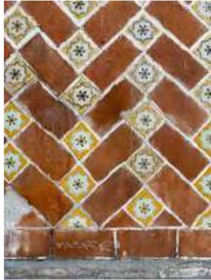
Ilustración 81. Detalle del petatillo que se desplanta de una hilada de ladrillo horizontal. Foto: Tomás Meraz, 2022.
