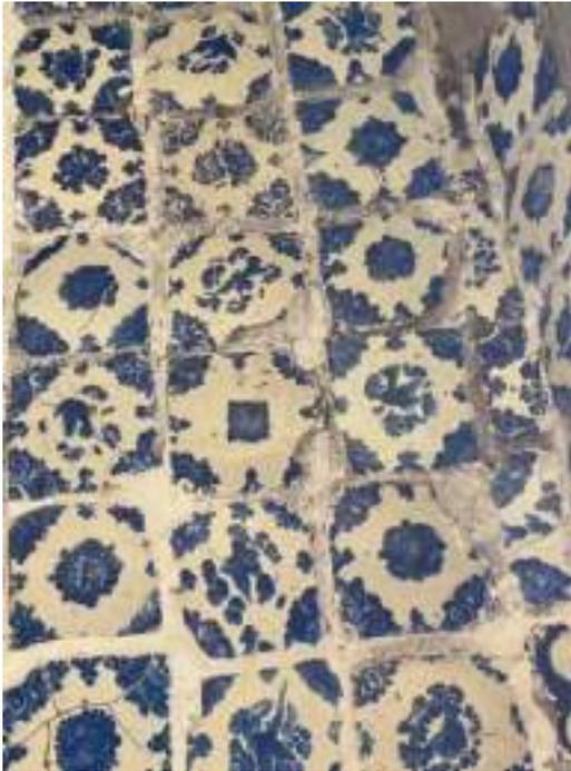
*Ilustración 173. Azulejos fracturados, con pérdida de juntas y presencia de resanes. Banqueta de la cocina. Foto: Tomás Meraz, 2022.*
