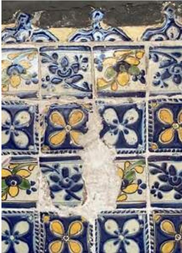
*Ilustración 170. Presencia de resanes con pegazulejo, lambrín del muro Sur del patio.
