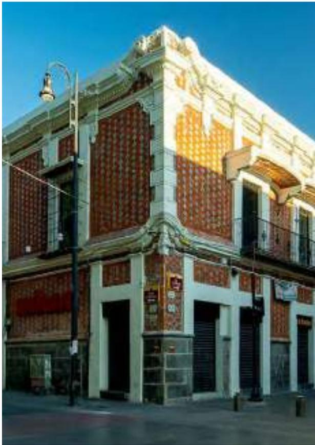
*Ilustración 183. Detalle de la esquina donde se pueden ver las molduras mixtilíneas en argamasa.
