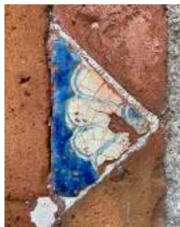
*Ilustración 105. Acercamiento a una de las piezas que presenta desprendimiento del esmalte por las cuarteaduras naturales de la parte vidriada. Foto: Tomás Meraz, 2022.*
