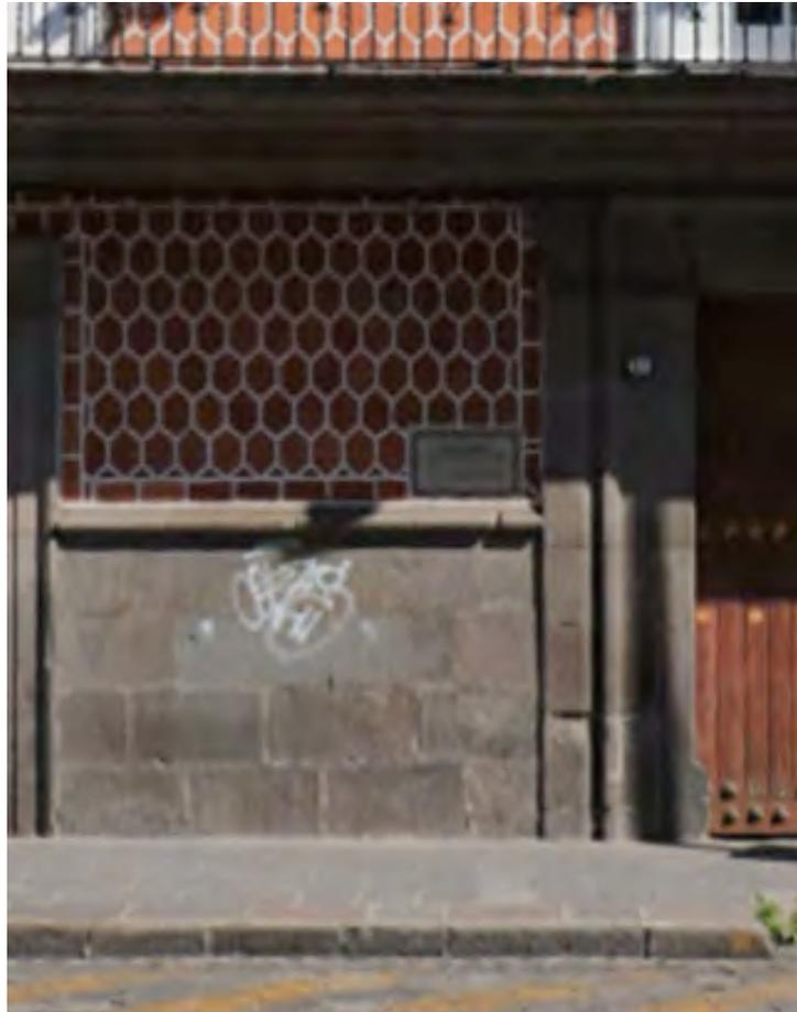
*Ilustración 192. Presencia de pintas con pintura en aerosol presentes en el guardapolvo de cantera. Foto: Tomás Meraz, 2022.*
