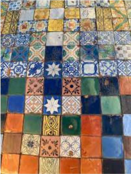
*Ilustración 91. Detalle de la cúpula del presbiterio con azulejos muy posiblemente reutilizados, se muestra la gran variedad de diseños identificados. Foto: Tomás Meraz, 2022*
