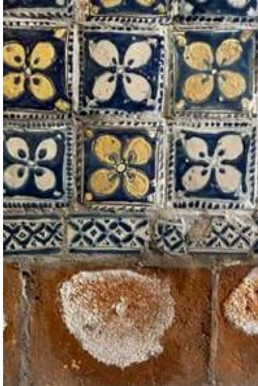
*Ilustración 167. Parte baja del lambrín de la portería. Se puede identificar eflorescencia salina en los ladrillos. Foto: Tomás Meraz, 2022.*
