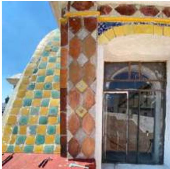
*Ilustración 121. Pérdida de piezas de talavera y sustitución por mortero de cemento. Foto: Tomás Meraz, 2022.*
