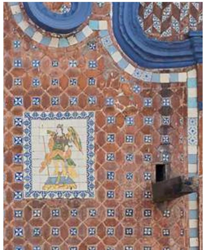
*Ilustración 64. Sección superior derecha de la fachada. Se observa una sección faltante en el tablero de San Rafael, así como utilización de azulejos con diseño diferente en la esquina superior derecha. Fotografía: Tomás Meraz, 2022*
