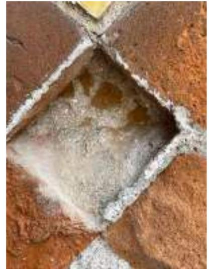
*Ilustración 85. Detalle de pieza ya perdida, se observan juntas de cemento, mortero disgregado y ladrillos afectados por los ciclos de cristalización de sales. Foto: Tomás Meraz, 2022*
