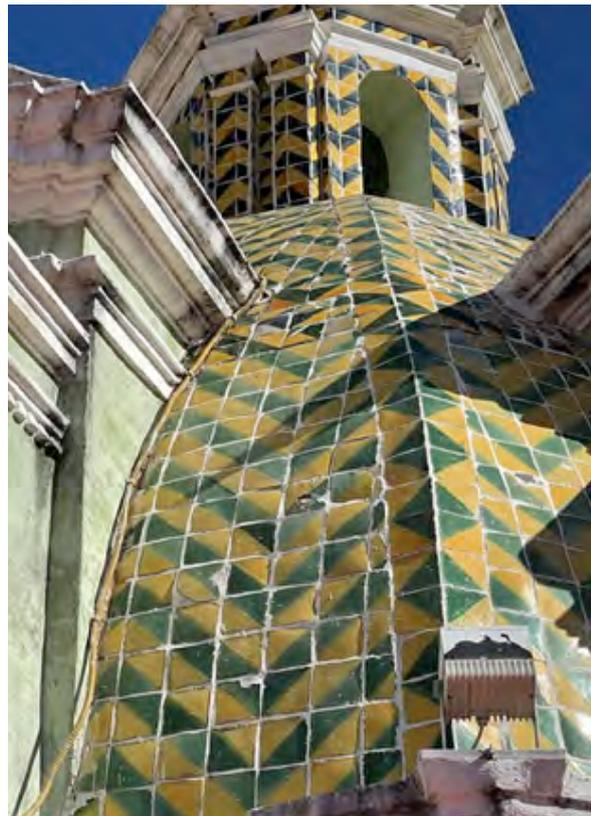
*Ilustración 67. Vista parcial del vértice SE. Se observa una nervadura de la cúpula, marcada por una disposición diferente (en cuarto) de las piezas de medio pañuelo, para formar rombos verdes. Fotografía: José Ignacio Lanzagorta, 2022*
