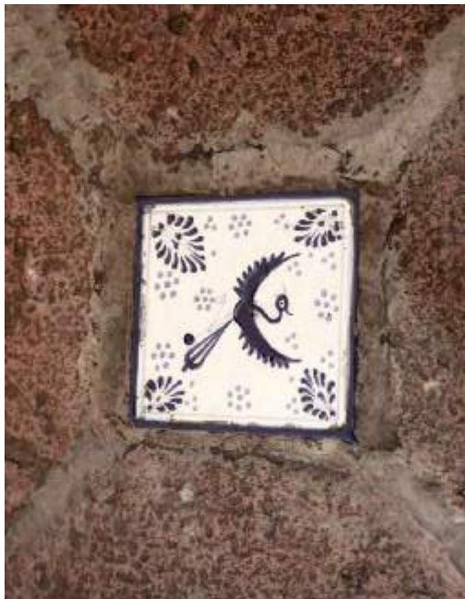
*Ilustración 180. Azulejo contemporáneo, instalado en sustitución de una pieza original. Foto: José Ignacio Lanzagorta, 2022.*
