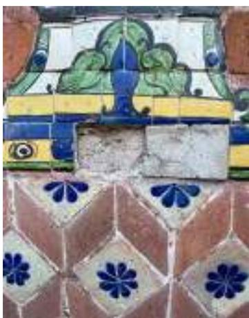
*Ilustración 103. Detalle de la base del tablero tres (contando de izquierda a derecha) donde faltan algunas piezas y están en riesgo las contiguas. Foto: Tomás Meraz, 2022.*
