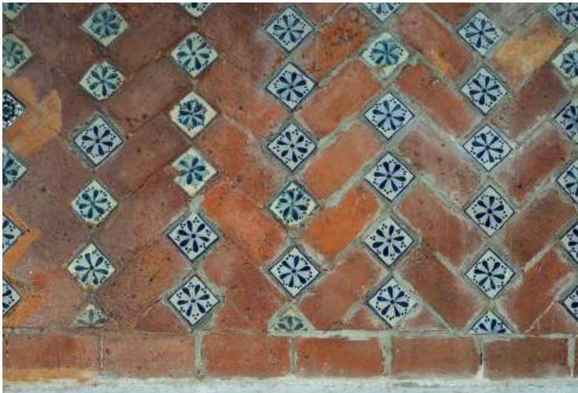
*Ilustración 188. Detalle donde se puede observar un número importante mayoría de piezas contemporáneas sustituyendo a piezas originales, que seguramente se han perdido. Foto: Tomás Meraz, 2022.*
