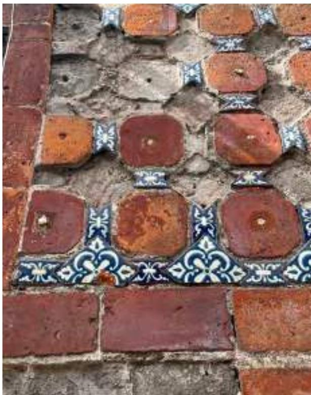
*Ilustración 201. Detalle de la decoración en el desplante de la fachada. Se observan las hiladas de solera enmarcando los paneles decorados. Foto: José Ignacio Lanzagorta, 2022.*
