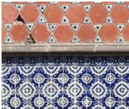
*Ilustración 199. Detalle de piezas octogonales de solera de ladrillo, reintegradas, con una coloración diferente a las originales, se observan resanes de cemento blanco y/o pegazulejo en las zonas de faltante de talavera. Paramento al costado derecho del acceso. Foto: Tomás Meraz, 2022.*
