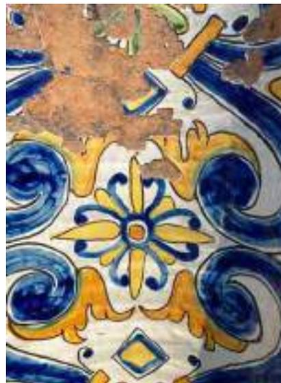
*Ilustración 61. Pieza cóncava de talavera, utilizada para cubrir las áreas de canalización de la cúpula. Se observa pérdida de la capade vidriado. Fotografía: Tomás Meraz, 2022.*
