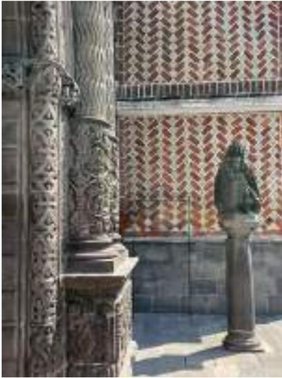
Ilustración 80. Detalle del paramento que conecta el hospital con la pequeña explanada del templo. Se observa el diseño de petatillo, logrado con piezas de solera de ladrillo rectangulares y azulejos de talavera. Foto: José Ignacio Lanzagorta, 2022.
