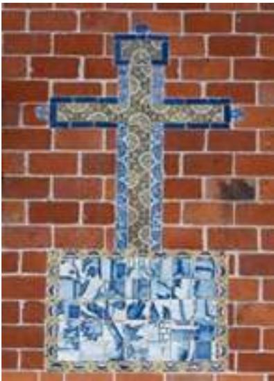
*Ilustración 77. Cruz de la sección izquierda de la fachada. En la base se puede observar que las piezas se encuentran desordenadas y no se puede tener una lectura clara del motivo que representan. Foto: Amy Bello, 2022.*
