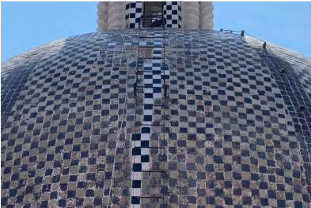
*Ilustración 154. Vista parcial de la cúpula donde se pueden ver mosaicos reintegrados que no corresponden con el original y cortan el panel decorado con una estrella. Foto: Tomás Meraz, 2022.*
