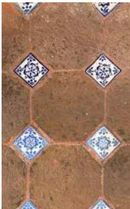
*Ilustración 116. Piezas de talavera de reciente manufactura que han sido colocadas en reposición de piezas que se han perdido. Se pueden ver las variaciones de tono y modificaciones muy ligeras en el diseño. Foto: Tomás Meraz, 2022.*
