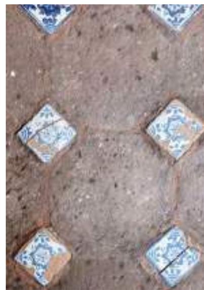
*Ilustración 117. Azulejos de talavera, aplicados en pisos, que se encuentran fracturados y con pérdida en la capa de vidriado. Foto: Tomás Meraz, 2022.*
