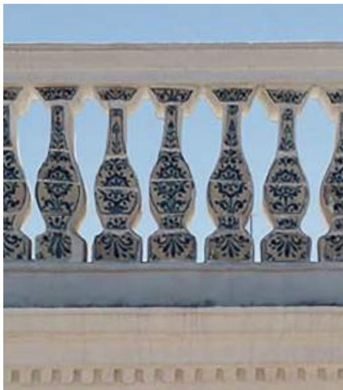
*Ilustración 141. Detalle de la balaustrada que remata la fachada Este. Se puede observar cómo cada balaustrada está cubierta con 6 piezas que se ajustan expofeso al perfil del elemento. Tomás Meraz, 2022.*
