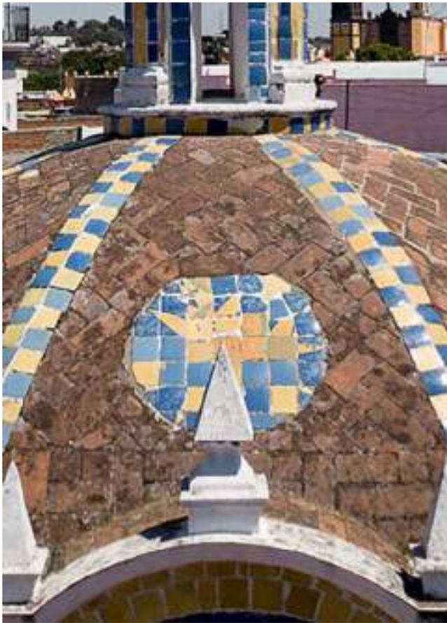
*Ilustración 193. Detalle de uno de los medallones con piezas en desorden. El diseño se encuentra alterado. Foto: Tomás Meraz, 2022.*
