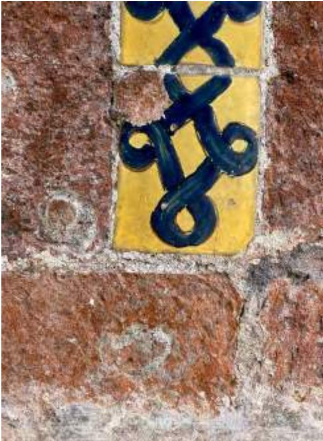
*Ilustración 145. Detalle del guardapolvo, en la esquina noroeste. Se observa un tono blanquecino sobre las piezas de solera de ladrillo, producto de cristalización de sales en superficie por humedad capilar. Foto: Tomás Meraz, 2022.*
