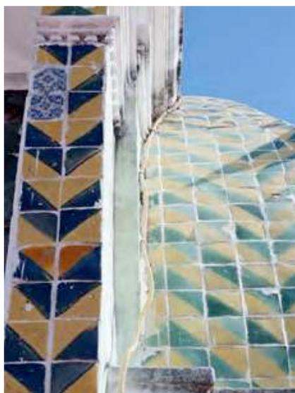
*Ilustración 69. Intervención posterior, colocando azulejos de talavera azul y amarillo, y con diseño floral, diferente al original. Se observa el recorrido de instalación eléctrica contemporánea. Fotografía: José Ignacio Lanzagorta, 2022.*
