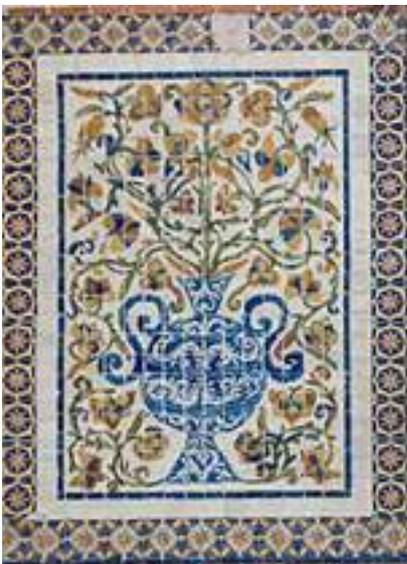
*Ilustración 79. Tablero del lado izquierdo de la fachada, presenta pérdida de una pieza con motivos geométricos del enmarcamiento. Foto: Amy Bello, 2022.*
