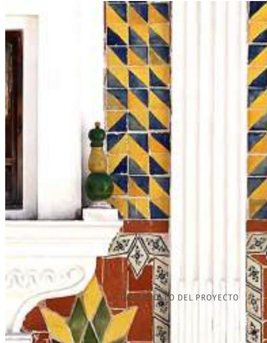
Ilustración 143. Pináculos de talavera, colocados a los costados de las ventanas del segundo piso en la fachada Este. Foto: Tomás Meraz, 2022.
