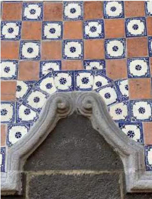
*Ilustración 206. Detalle de la fachada, se observa la disposición en damero de la decoración y el ajuste con piezas únicamente de talavera en el empalme con el guardapolvo. Foto: Tomás Meraz, 2022.*
