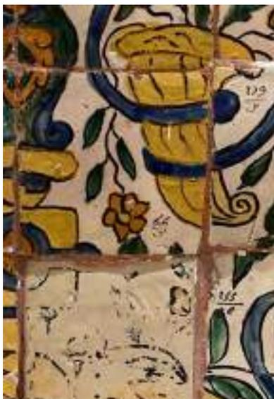
*Ilustración 115. Una pieza de reposición en el lambrín de la sacristía, que ha perdido color y diseño. Foto: Tomás Meraz, 2022.*
