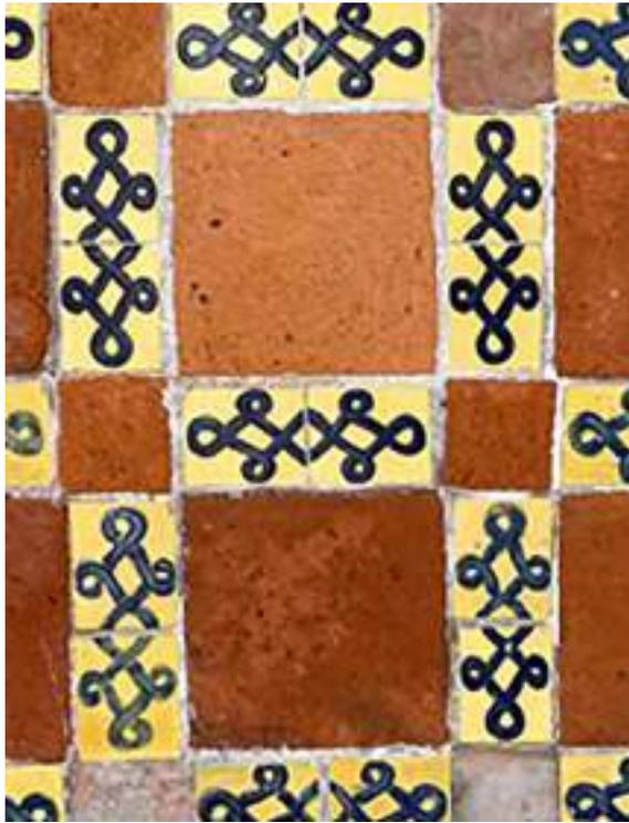
Ilustración 142. Acercamiento del guardapolvo. El diseño en forma de nudo se logra utilizando dos piezas. El panel se forma alternando una línea de azulejos en vertical y una en horizontal. Con las piezas de solera de ladrillo cuadrangular intercaladas. Foto: Tomás Meraz, 2022.
