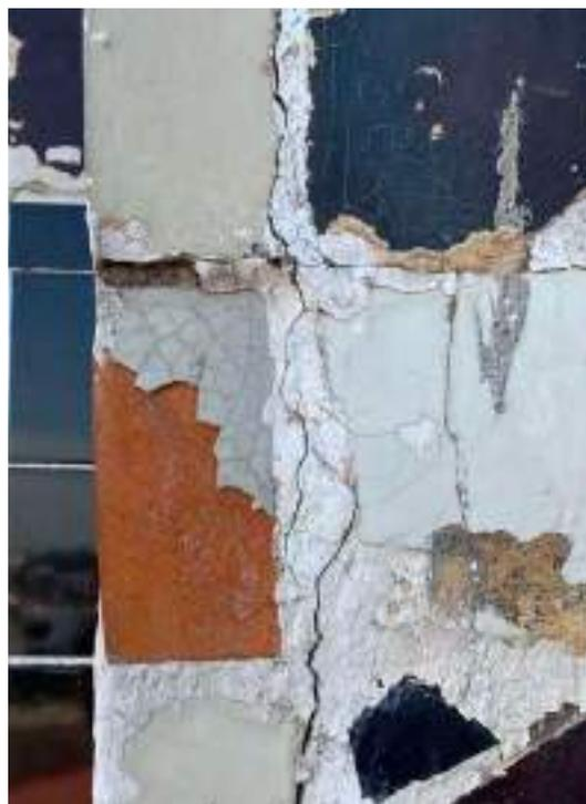
*Ilustración 151. Detalle pieza que ha perdido parte del vidriado, dejando expuesto el soporte. Foto: Tomás Meraz, 2022.*
