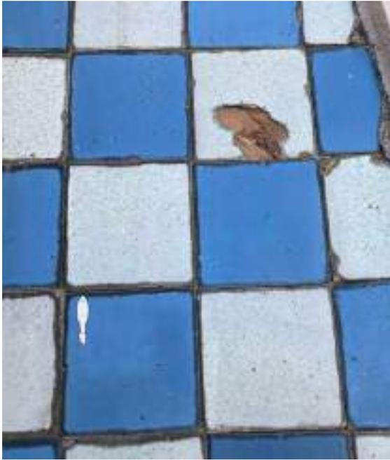
*Ilustración 96. Piezas fracturadas en la cúpula del transepto. Foto: Tomás Meraz, 2022.*
