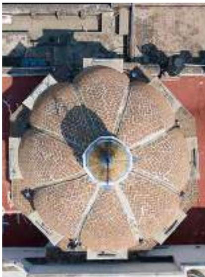
*Ilustración 59. Vista cenital de la cúpula, se aprecia la división en gajos, con piezas de talavera en forma de canaleta. Existen faltantes de estas piezas que han sido sustituidos por resanes de cemento. Fotografía: Tomás Meraz, 2022.*
