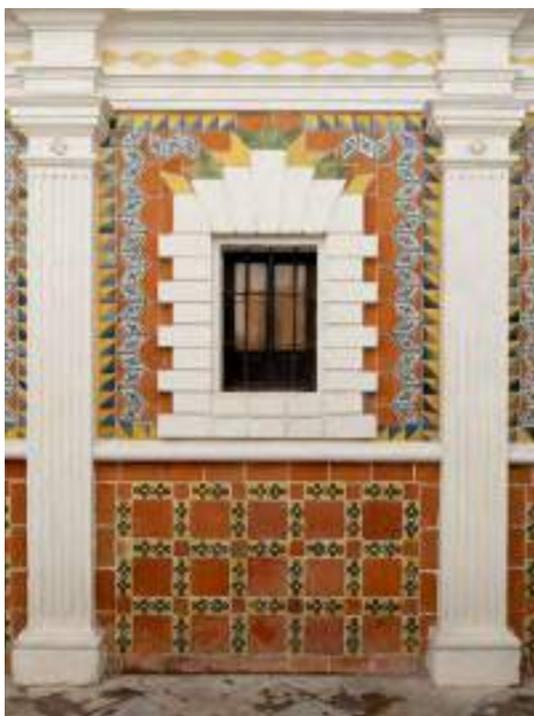
*Ilustración 139. Detalle del primer cuerpo de la fachada Este. Se puede observar el guardapolvo con mosaicos rectangulares y ladrillos cuadrados, y en el paramento del vano, tres tipos de azulejo: romboidales amarillos y verdes, romboidales con motivos florales en azul sobre blanco y una cenefa de piezas de medio pañuelo amarillo y azul. Foto: Tomás Meraz, 2022.*
