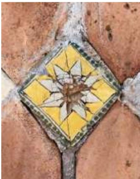
*Ilustración 120. Pérdida de vidriado y de la base de barro, debido a la fractura de la pieza. Foto: Tomás Meraz, 2022.*
