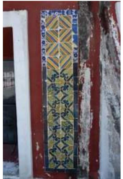
*Ilustración 134. Detalle de uno de los tableros-tapiz a los costados de los vanos. Se observa una inclusión de una sección de otro programa decorativo. Foto: Tomás Meraz, 2022.*
