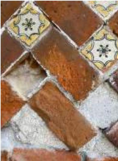
*Ilustración 83. Detalle de la parte baja del diseño de petatillo de la fachada, se observa pérdida de piezas y exposición del mortero de cal y arena. Foto: Tomás Meraz, 2022.*
