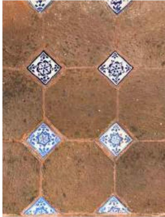
*Ilustración 110. Piso en el segundo nivel del inmueble. Con diseño fitomorfo azul sobre blanco. Se puede observar piezas de reposición modernas, con un color azul más claro. Foto: Tomás Meraz, 2022.*
