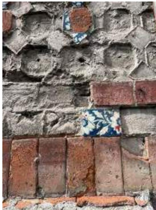
*Ilustración 203. Dos detalles del nivel de pérdidas que presenta la fachada. Algunas piezas, de la parte baja se encuentran propensas para ser saqueadas (como ha ocurrido), mermando la estabilidad y continuidad del recubrimiento. Foto: José Ignacio Lanzagorta, 2022.*
