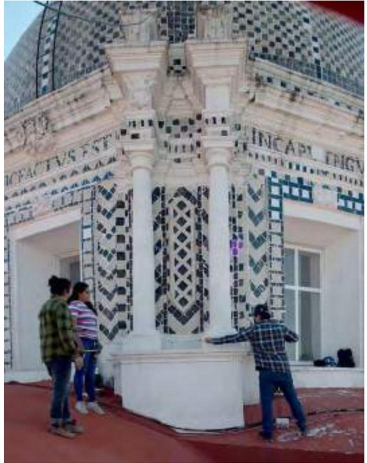
*Ilustración 34. Medición para levantamientos arquitectónicos. Fotografía: Amy Bello Sandoval, 2022*
