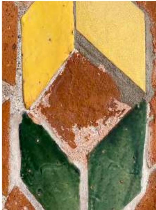
*Ilustración 147. Detalle de la balaustrada sobre la tercera calle de la fachada este. Se observan piezas fracturadas que se recolocaron en su sitio con un mortero no identificado. Foto: Tomás Meraz, 2022.*
