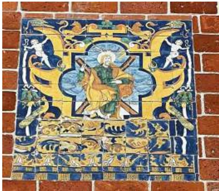
*Ilustración 78. Detalle del tablero de San Andrés, en las hiladas de la parte inferior los azulejos se encuentran en desorden, es posible que estas piezas se hayan colocado en reposición de piezas faltantes. Foto: Tomás Meraz, 2022.*
