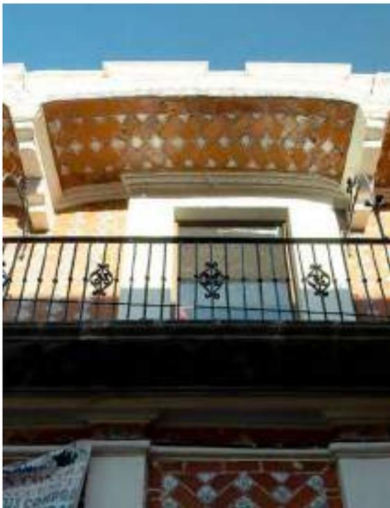
*Ilustración 185. En el intradós de la cubierta del balcón se observa el mismo patrón de petatillo con solera de ladrillo y azulejos de talavera.
