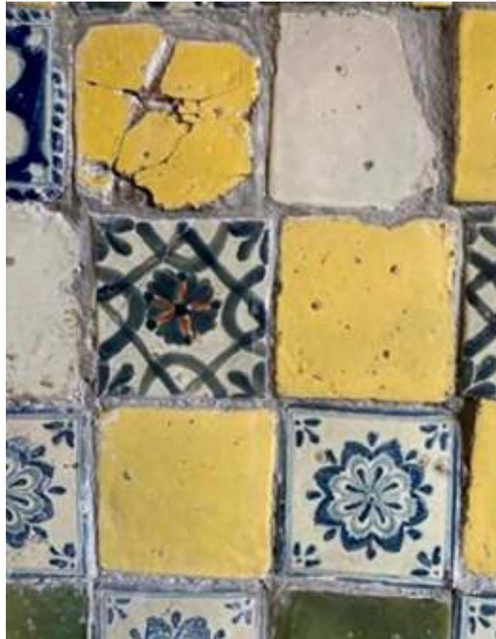
*Ilustración 169. Pieza de talavera fracturada en el lambrín del corredor que conecta la portería con el patio. Foto: Tomás Meraz, 2022.*
