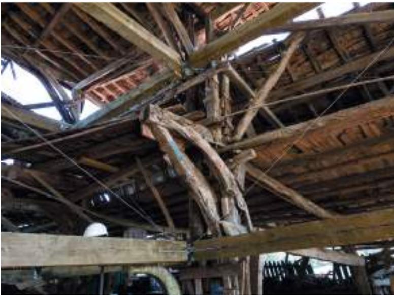
Arriba: Vista interior de la nave principal de los astilleros Mendieta. Puede verse la fragilidad de la estructura y sus deformaciones. Abajo: Los estabilizadores ya colocados en el edificio, respetan todos los elementos, principales, secundarios y menores, del mismo. © Mikel Landa.
