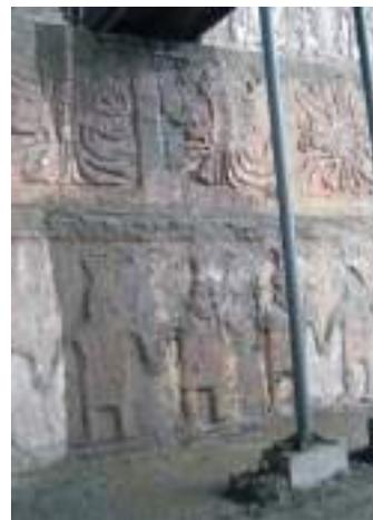
Figura 15. El proceso de investigación para la conservación y monitoreo busca una respuesta físico-mecánica a lo largo de 26 años de exposición a la intemperie. Comprobándose la resistencia al viento abrasivo y eventuales escorrentías pluviales.
