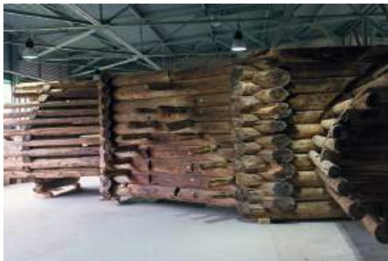
La misma franja, vuelta a montar en taller, para comprobar los ajustes, antes de volver a ser desmontada y vuelta a montar definitivamente en el sitio, antes de la llegada del invierno.
