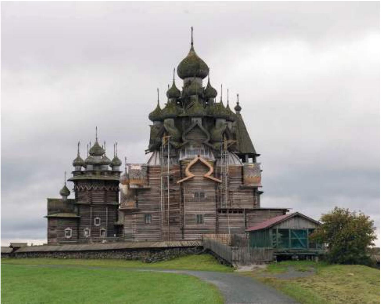
Vista exterior del edificio y la zona a intervenir en el año 2016. La franja correspondiente de troncos se ha desmontado para proceder a la reparación de los elementos dañados y a la sustitución de los irrecuperables.
